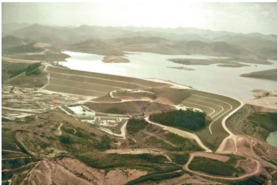
Figura 1 - Barragem e dique principal da UHE Paraibuna
