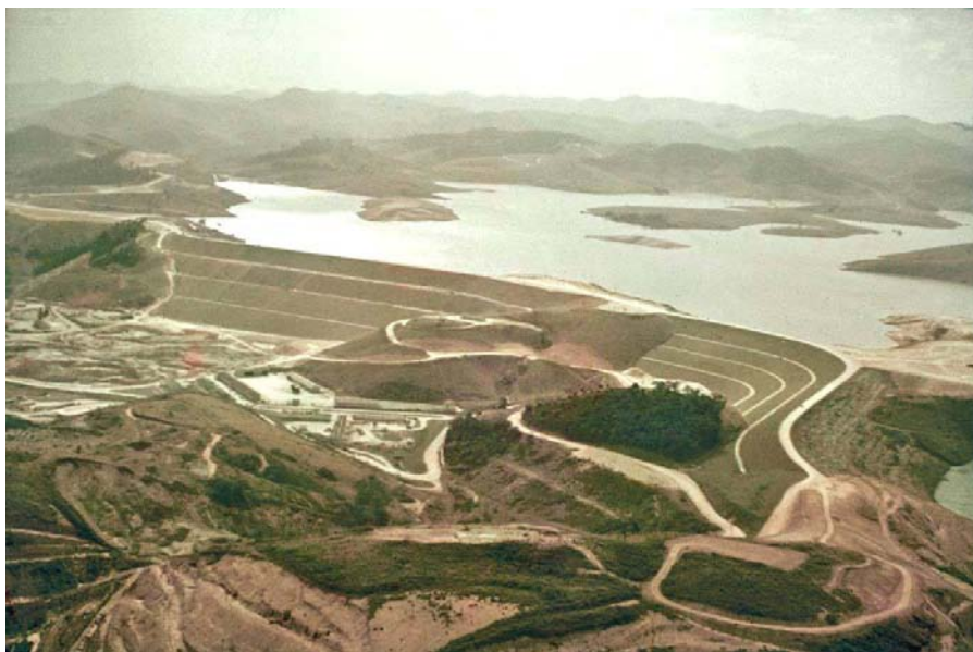
Figura 1 - Barragem e dique principal da UHE Paraibuna
